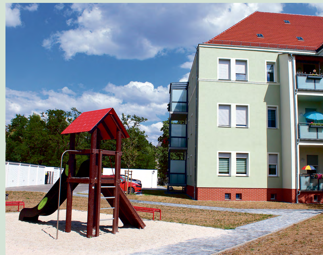
Die Sanierung der mehr als 90 Jahre alten „Beamtenhäuser“ auf dem Schomberg wurde 2021 abgeschlossen. Das Gebäude mit der Nummer 16 war das letzte der drei Wohnhäuser, das aufwendig erneuert wurde. Entstanden sind moderne Wohnungen in einem ansprechenden Umfeld, zu dem auch ein kleiner Spielplatz gehört.
