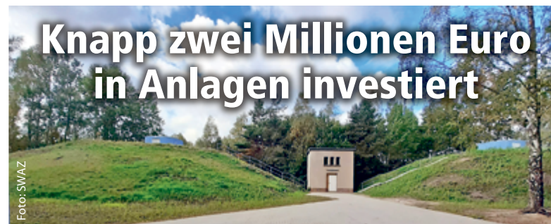
Die Reinwasserbehälter – innen saniert und mit neuer Technik ausgestattet.
